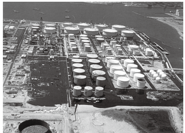
図3 1978年宮城県沖地震の際の仙台市内の製油所における重油の大量流出(河北新報社撮影)
